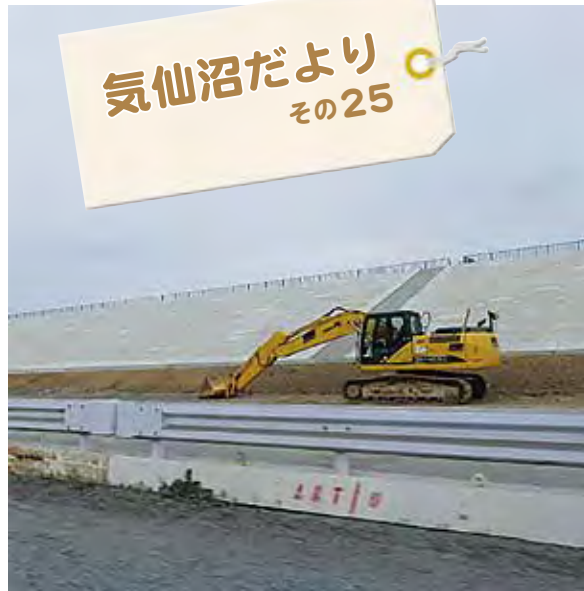
防潮堤の工事はつづく(2020年9月)
