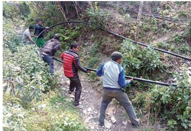
給水パイプの敷設 「ありがとう! 2ヵ月ぶりの安全な水を」
