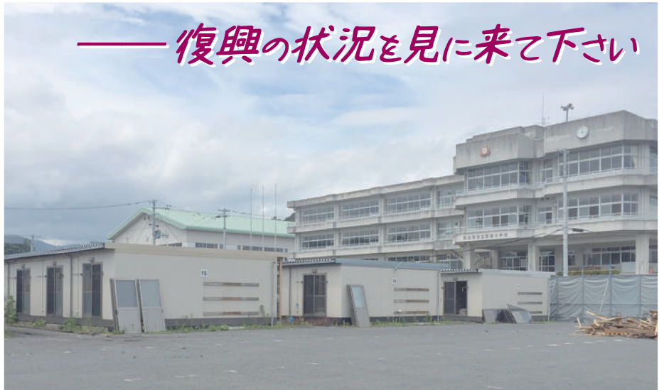
ようやく、撤去が始まった学校敷地内の仮設住宅
