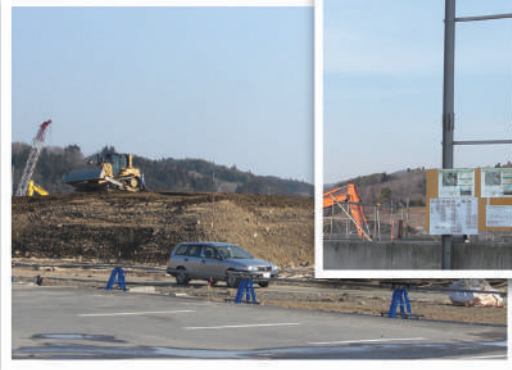
車の高さより高く、5mの盛り土工事をしている現場
