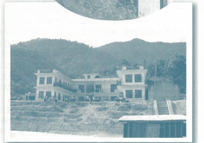
校舎の屋上に図書室を建てる
